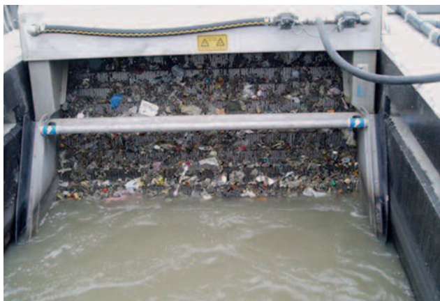
Ступенчатая решетка HUBER STEP SCREEN® SSF: длина 3500 мм, ширина 1826 мм, ширина щели 6 мм, угол установки 50°. Высокая производительность достигается за счет одного прохождения потока через поверхность решетки.
