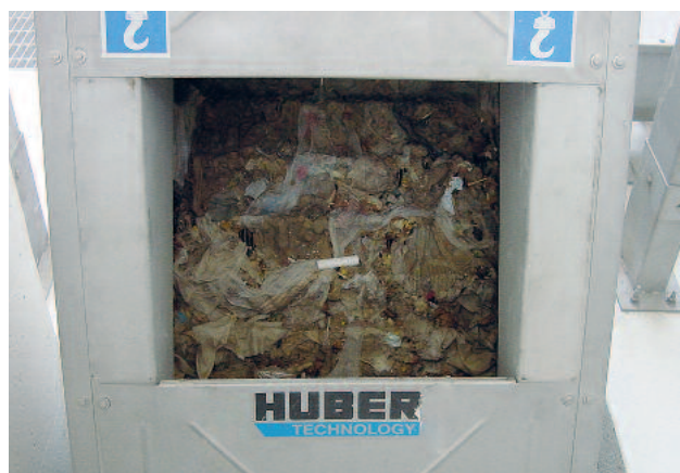
Ступенчатая решетка HUBER STEP SCREEN® SSF: очень устойчивая и надежная работа без повреждения песком, гравием и камнями благодаря специальной конструкции нижней части ступеней для поднятия отбросов на верхний уровень.
