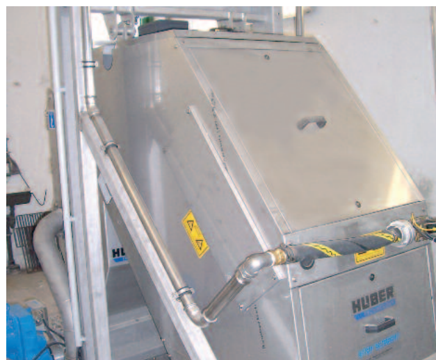
Полностью закрытая конструкция ступенчатой решетки HUBER STEP SCREEN® SSF, не пропускающая запах
