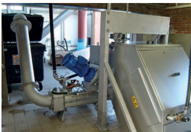
Ступенчатая решетка HUBER STEP SCREEN® SSF в сочетании с моечным прессом HUBER WAP® для интенсивной промывки отбросов. Полностью закрытая конструкция, не пропускающая запах.
