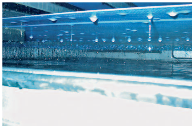
Внутри камеры фильтрации
