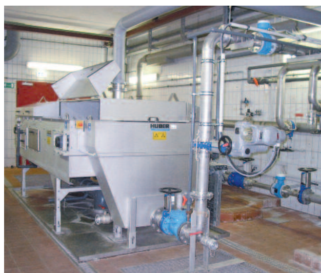
Ленточный сгуститель HUBER DrainBelt. Производительность - 60 м 3 жидкого осадка в час
