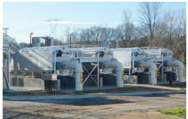
4 самопромивних дискових мікрофільтрів RoDisc® з 18 дисками в кожному, встановлених у бетонному резервуарі
