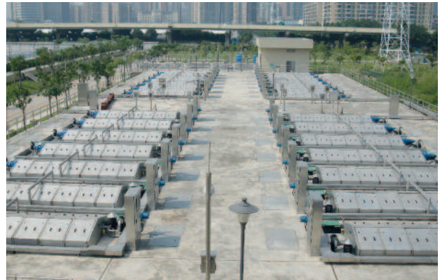
28 установок самопромивних дискових мікрофільтрів RoDisc® з 24 дисками у кожному. Очищують приблизно 8.5 м 3 стічних вод в секунду
