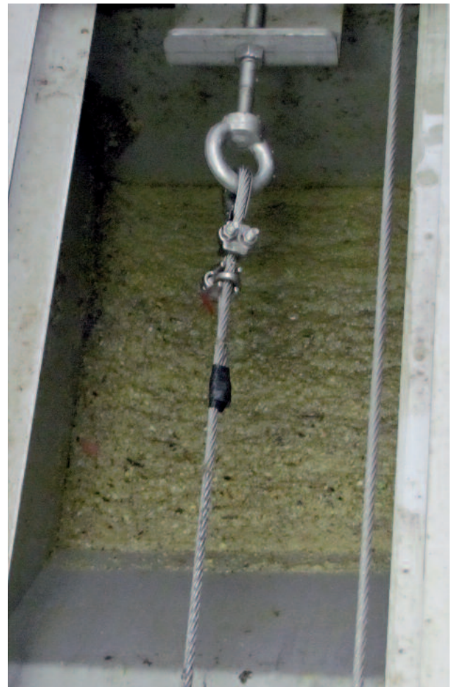
Рухомий скребок збирає плаваючий шар жиру у накопичуючий резервуар, який розташований у торці установки
