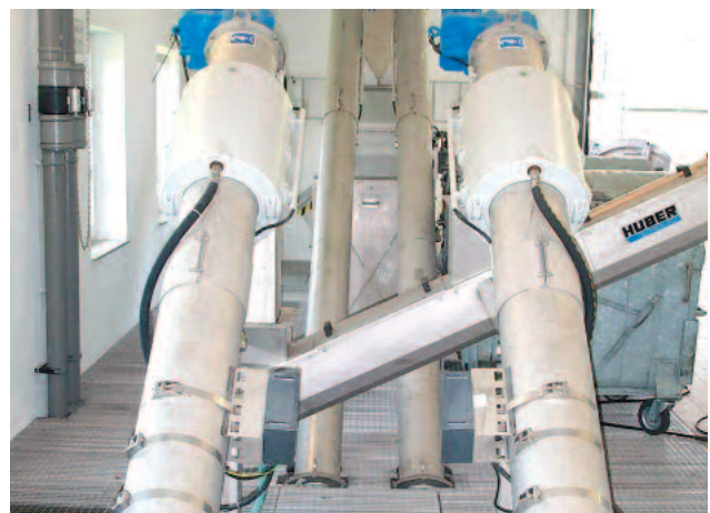
Установка Ro 5, підземне виконання
