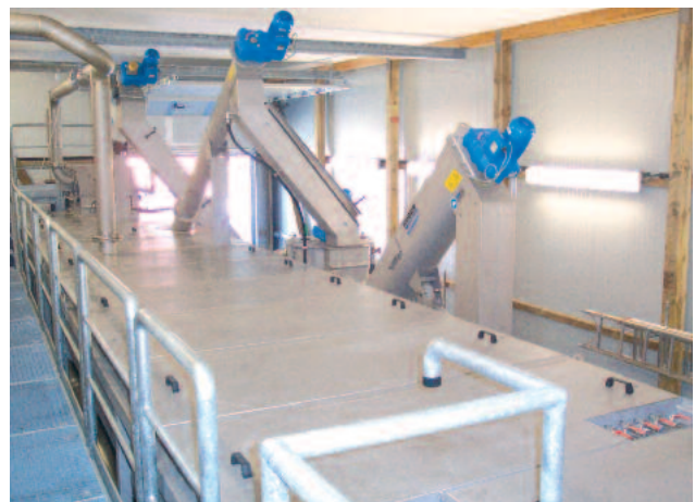
Герметичне вивантаження відходів і піску з установки Ro 5 виключає поширення запаху
