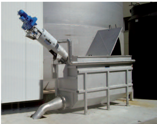
Барабанна решітка з обертовою гребінкою HUBER ROTAMAT® Ro1 у резервуарі
