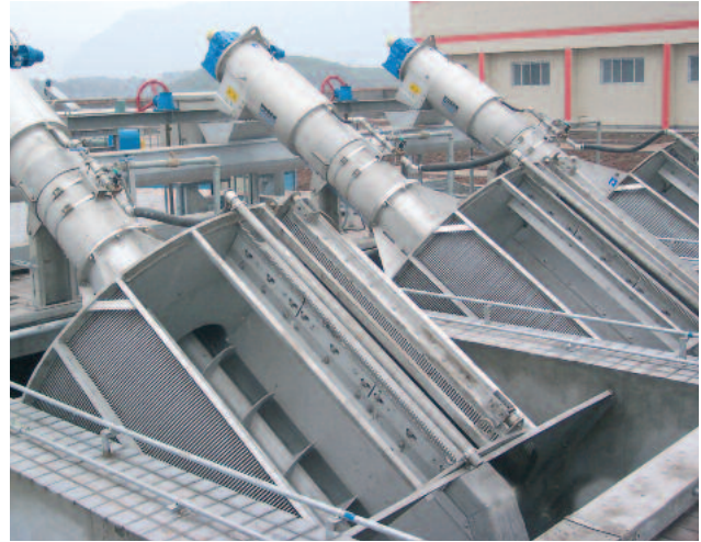
Декілька паралельно встановлених у каналі барабанних решіток з обертовою гребінкою HUBER ROTAMAT® Ro1
