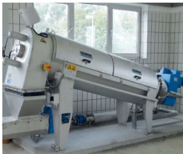
Стационарний шнековий прес. 3 м³/ч мокрого осаду
